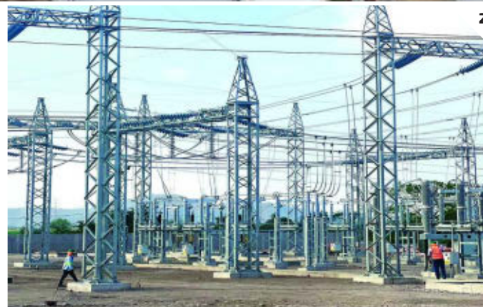
El Gas Natural Licuado (GNL) se trasladará de una terminal de Puerto Cortés a la planta de Brassavola en Villanueva, Cortés.
