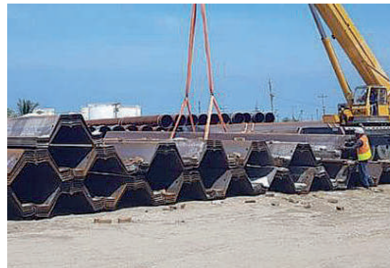
La empresa ya importó material y equipo desde China para preparar la infraestructura, aunque falta mucho para poner en marcha la obra.
