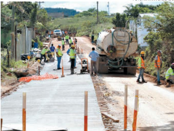
Se está realizando la fundición con concreto hidráulico en uno de los carriles de la carretera que conduce hasta Azacualpa.
