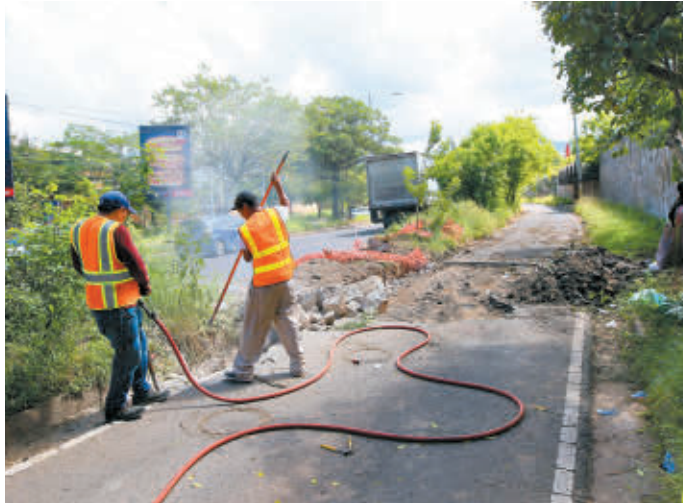
Ayer comenzaron con los trabajos en la zona. El puente ayudará a cruzar el bulevar y tendrá acceso directo a la Teletón.
