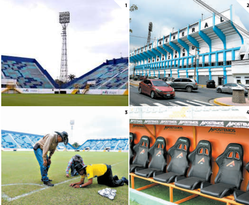
(1) Las autoridades que administran el Estadio Morazán están trabajando en mejorar el alumbrado. (2) El escenario fue remodelado y está en muy buenas condiciones. (3) La cancha híbrida ha respondido muy bien y se le da mantenimiento. (4) Las nuevas sillas para los suplentes son muy cómodas.
