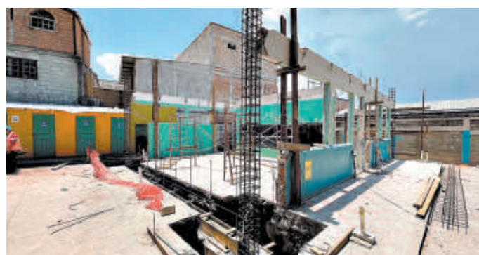
Este es el albergue que se construye en la Betania, la capacidad es para 250 personas y tendrá sus propios baños y otros espacios.
