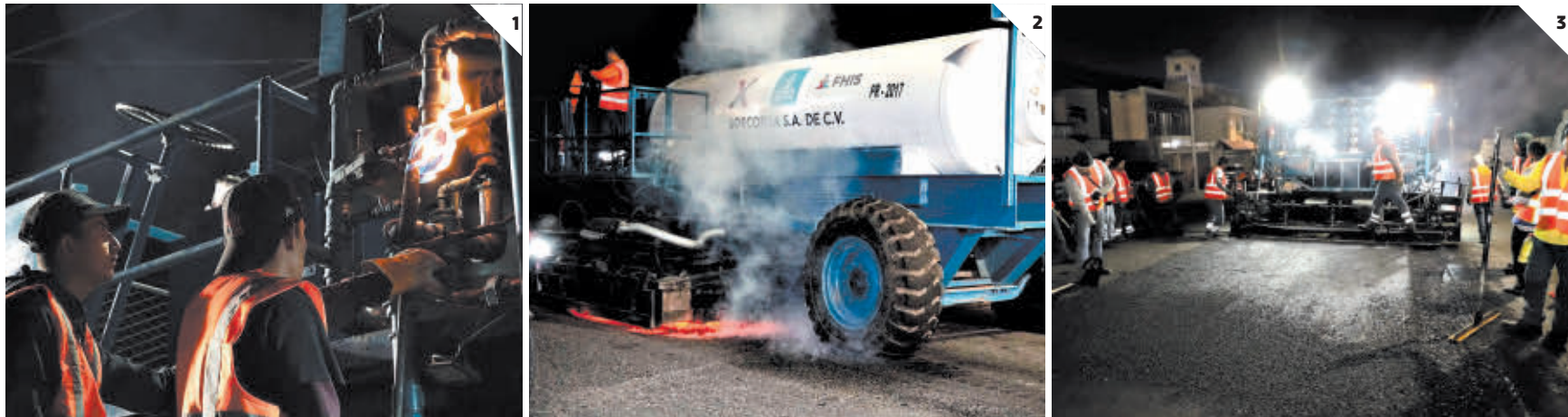
(1) Desde que iniciaron los trabajos, la maquinaria, según la comuna, ha trabajado en unos cinco kilómetros. (2) La comuna detalló que nunca habían tenido tanta demanda de asfalto para hacer funcionar la maquinaria. (3) Los trabajos que son exclusivamente nocturnos, si la maquinaria es abastecida pueden cubrir un kilómetro con un ancho de tres metros.
